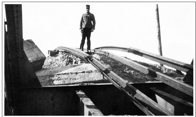
Magyar katonatiszt a felrobbantott Mura-hídon Muraszerdahelynél 1941-ben. (Fortepan, Karabélyos Péter)
