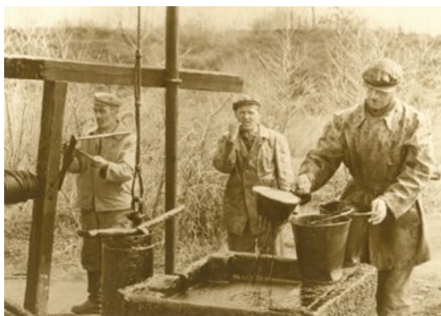
➤ Pridobivanje nafte z ročnim vitlom v Peklenici v Medžimurju (1946) (Fotografija: Fotoarhiv GML)
