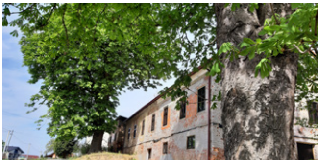
• A tájház a felújítás alatt áll.
